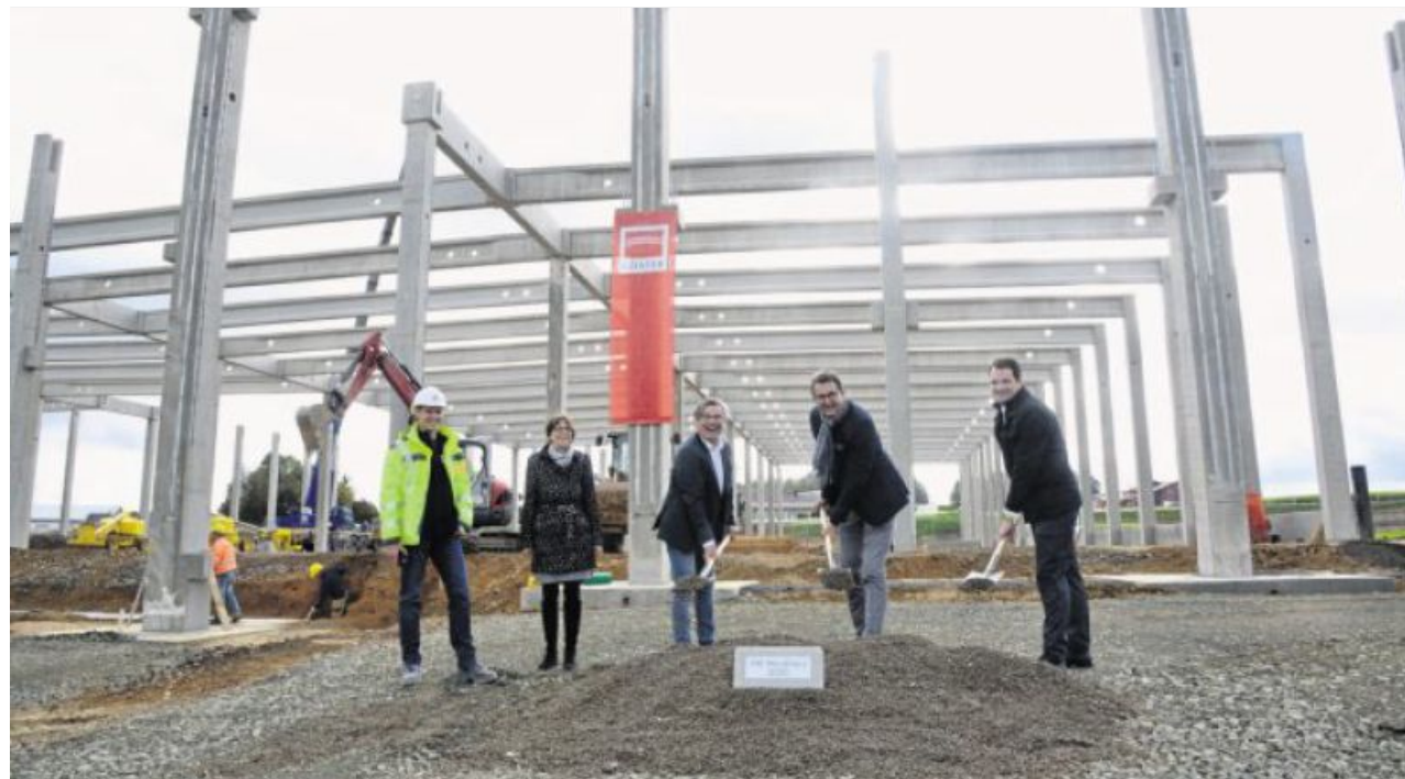
Projektleiter Volker Gradl, Köster Bau, und stellvertretende Landrätin Margit Kirzinger (von links) beobachten Bürgermeister Reiner Gäbl, Martin Pfandzelter (VIB Vermögen) und Uli Dippel (Tech Data), wie sie den Grundstein zuschaukeln. Bild: bey
